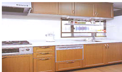
リフォーム工事
